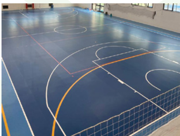
Pavimentazione indoor in resina
