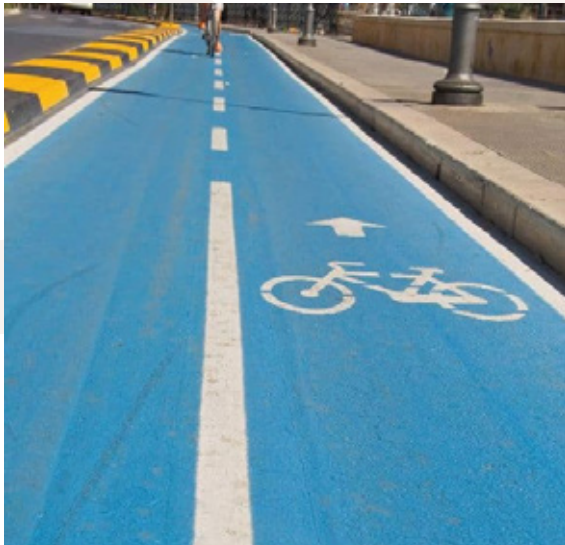
Pista ciclabile in asfalto colato
