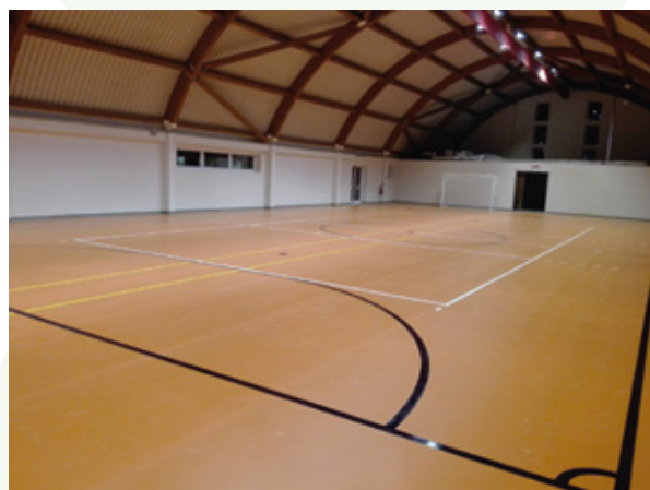
Pavimentazione in vinilico flessibile
