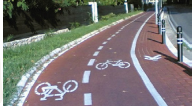
Pista ciclabile in asfalto colato
